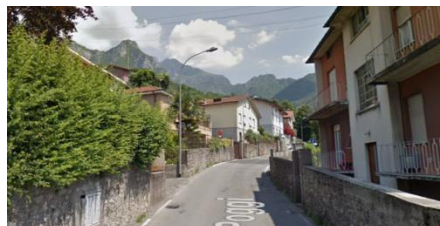
Tipo F: strada locale
