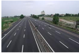
Tipo A: autostrade
