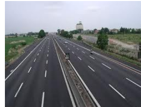
Tipo A: autostrade
