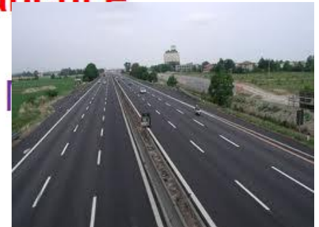
Tipo A: autostrade
