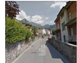
Tipo F: strada locale
