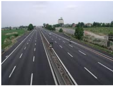
Tipo A: autostrade
