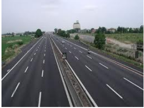
Tipo A: autostrade
