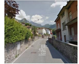
Tipo F: strada locale
