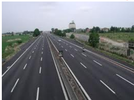
Tipo A: autostrade
